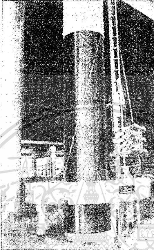
รูปที่ 11 ลักษณะการดำเนินการหุ้มผิวของเสาตอม่อของอาคารขนาดใหญ่
