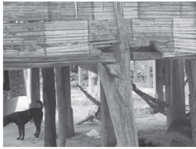
รูปที่ 9 เสาไม้งามและฝาฟากสับ เรือนนายทองสุข น้อยเสลา ที่มา: รวบรวมข้อมูลโดยผู้วิจัย
