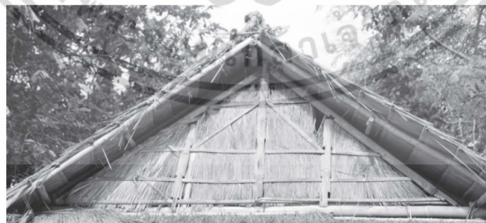
รูปที่ 14 ลักษณะการเข้าไม้ในส่วนหลังคาเรือนญ้อ
