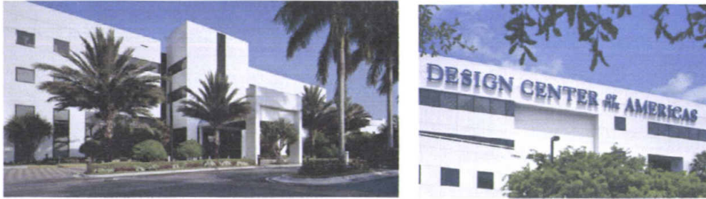
รูปที่ 3.26 แสดงลักษณะภายนอกอาคาร DCOTA
