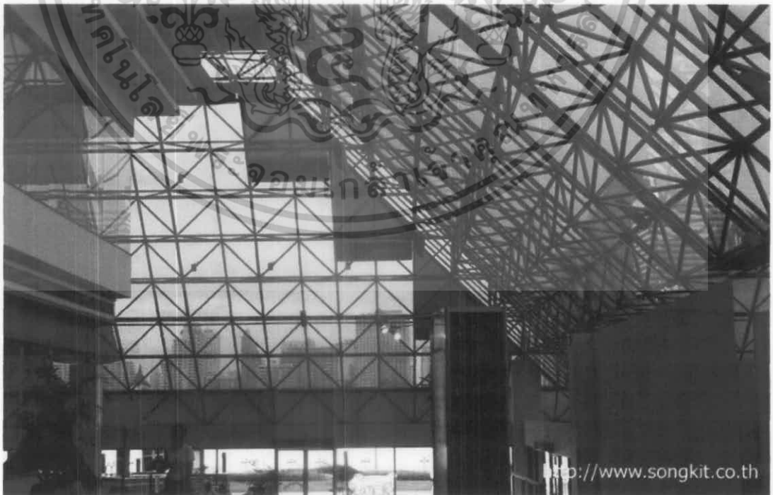
รูปที่ 6.19 แสดงภาพแสดงโครงเหล็กถักสำเร็จรูป (Space Frame)
