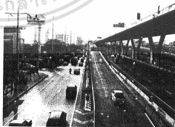
ภาพ 4.15 แสดง สภาพการจราจรด้านหน้าที่ตั้งโครงการ
