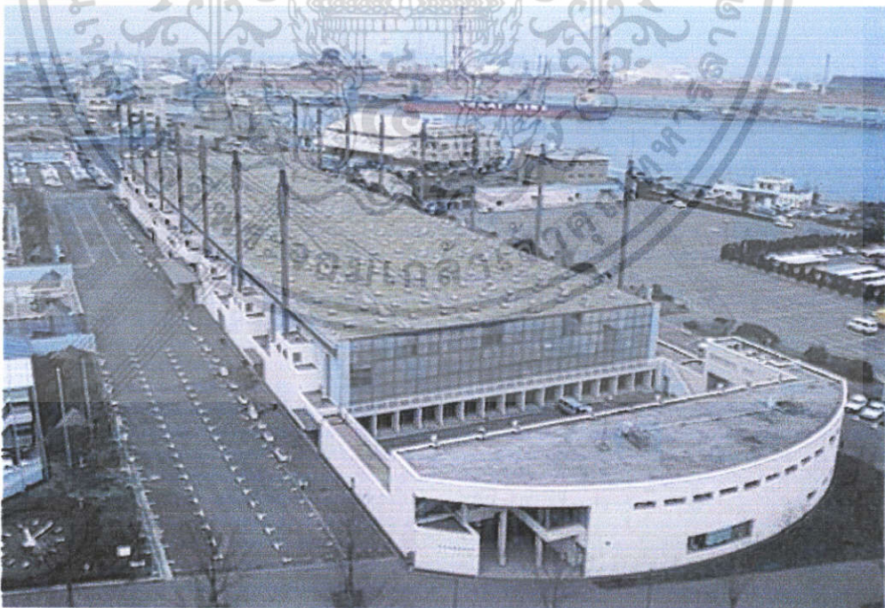
รูปที่ 3.4-3 แสดงภาพแสดงการใช้สายเคเบิลยึดโครงสร้างอาคาร
