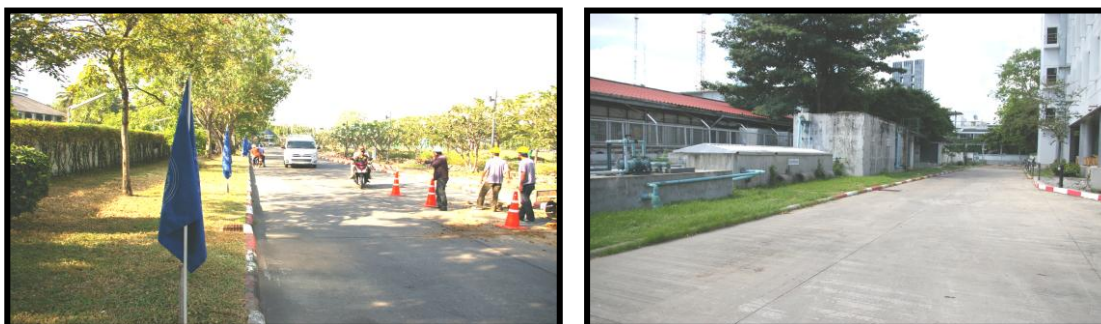
ภาพที่ 4.11 แนวถนนภายในฝั่งทิศใต้(ด้านประตูนางลิ้นจี่) และด้านข้างพื้นที่การประปาฯ
