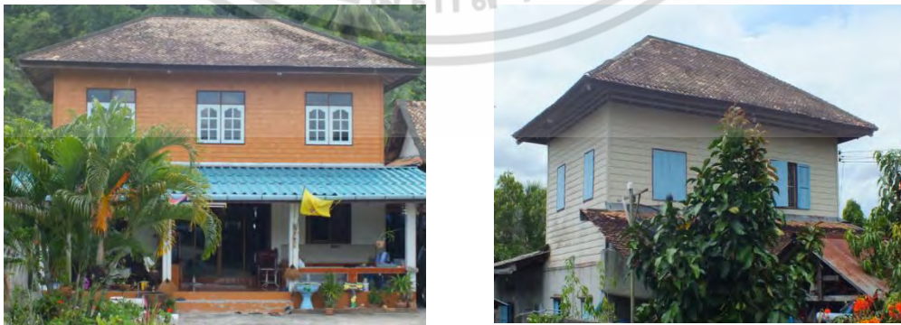
ภาพที่ 4.40 แสดงรูปแบบของผนังไม้ที่มีการซ่อมแซมแล้ว (ที่มา : จากการสำรวจ เดือน พฤศจิกายน พ.ศ. 2556)
