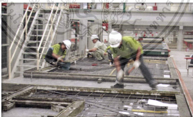
รูปที่ 4.7 แสดงการวางวางเหล็กเสริม วัสดุฝัง
