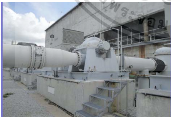
รูปที่ 4 แสดงปั๊มคูลลิ่งแบบแรงเหวี่ยง
