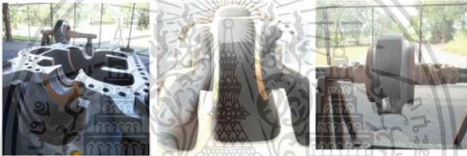
รูป ข- 3 แสดงการทำความสะอาดผิวหลังพ่นทรายด้วย Steam
