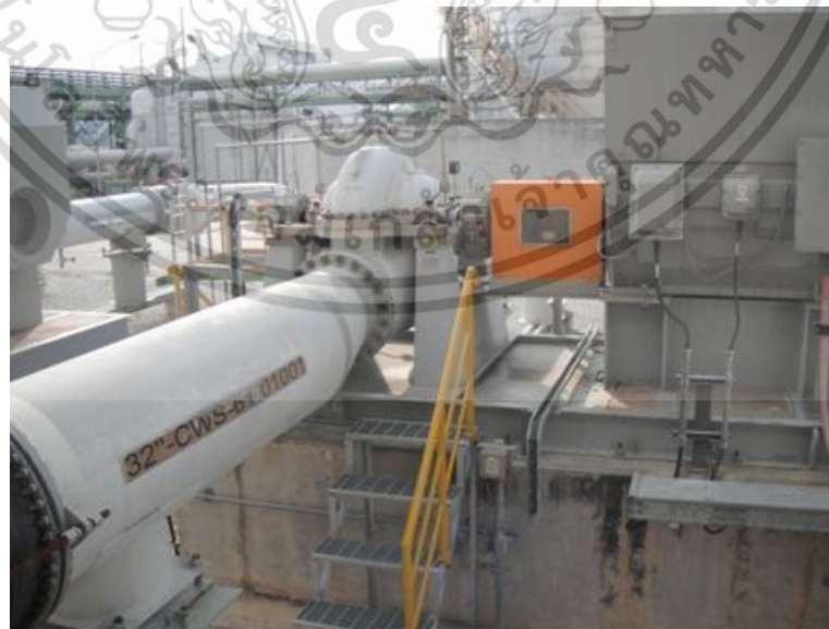
รูปที่ 3.3 ปั๊มแบบแรงเหวี่ยงที่ใช้ในการทดสอบ
