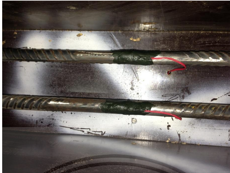
รูปที่ 4.24 การหุ้ม Coating Material ป้องกันการเสียหายของ Strain Gauge
