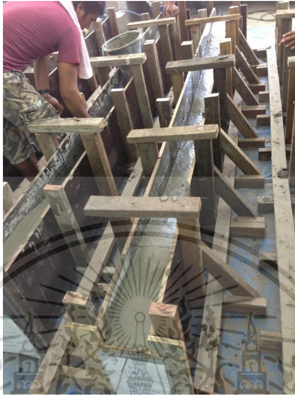
รูปที่ 4.32 การหล่อคานคอนกรีตมวลเบา 3 ชั้น-โค้ง (ต่อ)
