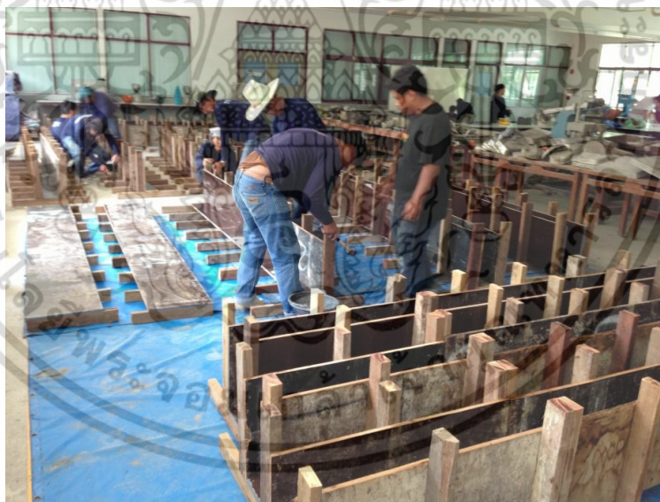
รูปที่ 4.19 ไม้แบบหล่อคานคอนกรีต
