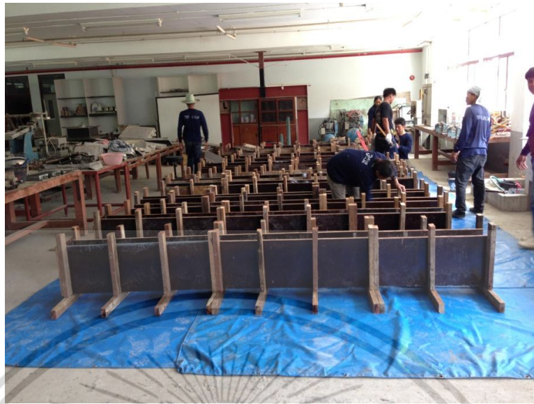
รูปที่ 4.20 ไม้แบบหล่อคานคอนกรีต (ต่อ)
