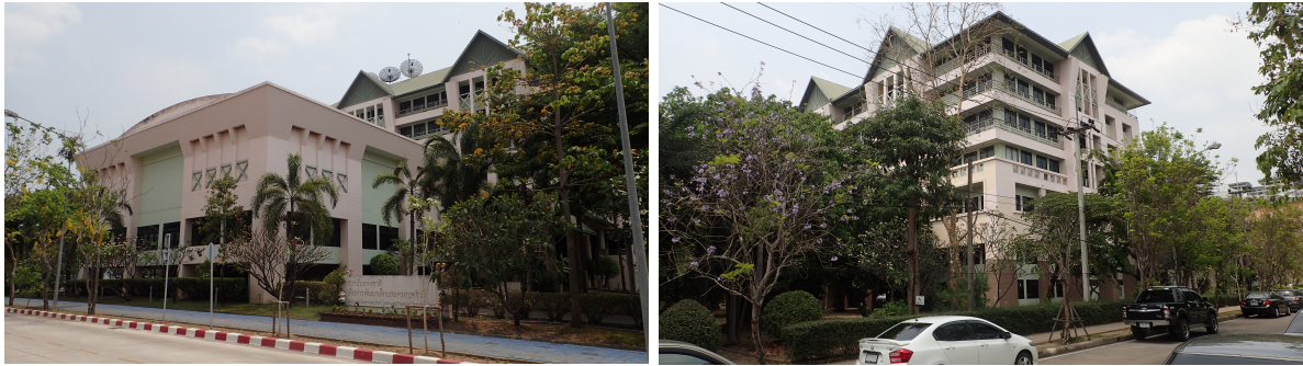
รูปที่ 2 แสดงภาพด้านหน้าอาคารปัญญาวัฒนาสูง 3 ชั้น (ซ้าย) ต่อเนื่องเป็นรูปตัวแอล ส่วนด้านหลังอาคารสูง 7 ชั้น (ขวา)
