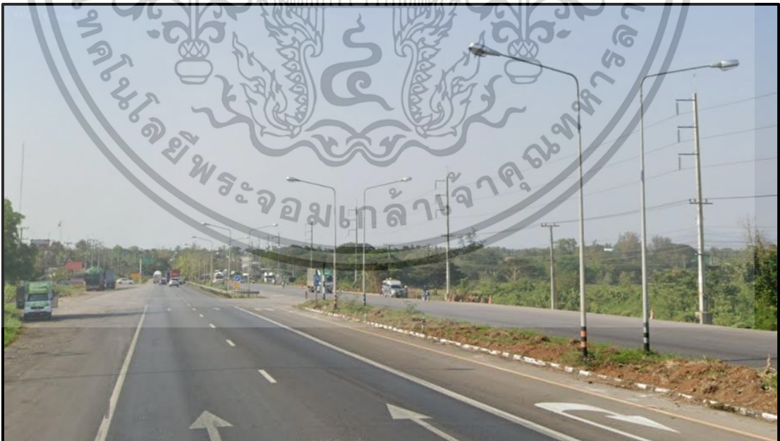
รูปที่ ง-2 กายภาพบนทางหลวงแผ่นดินหมายเลข 4 (ถนนเพชรเกษม) ช่วงถนน 2 (กม.286+035 ถึง กม.311+790)
