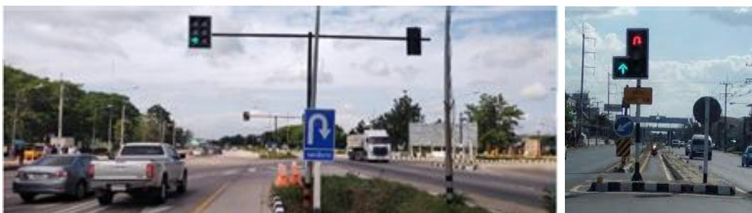
รูปที่ 2.7 ตัวอย่างรูปแบบจุดกลับรถโดยใช้สัญญาณไฟจราจรควบคุม
