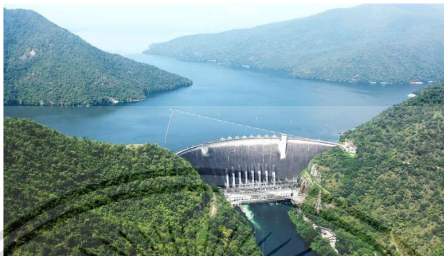
รูปที่ 2.2 เขื่อนภูมิพล จังหวัดตาก (เขื่อนคอนกรีตโค้ง)
