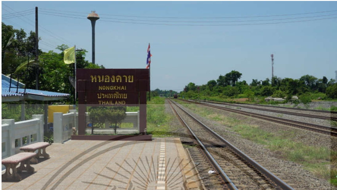
รูปที่ 4.14 สถานีรถไฟหนองคาย
