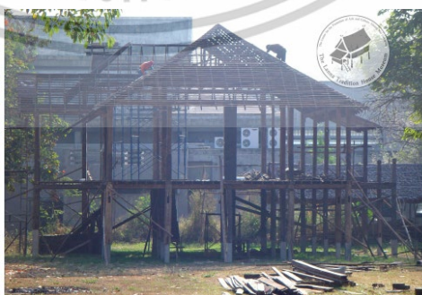
รูปที่ 2.14 การรื้อถอนแบบถอดประกอบ
