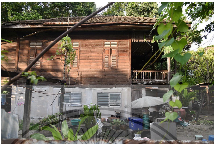
รูปที่ 4.79 องค์ประกอบผนังอาคาร
