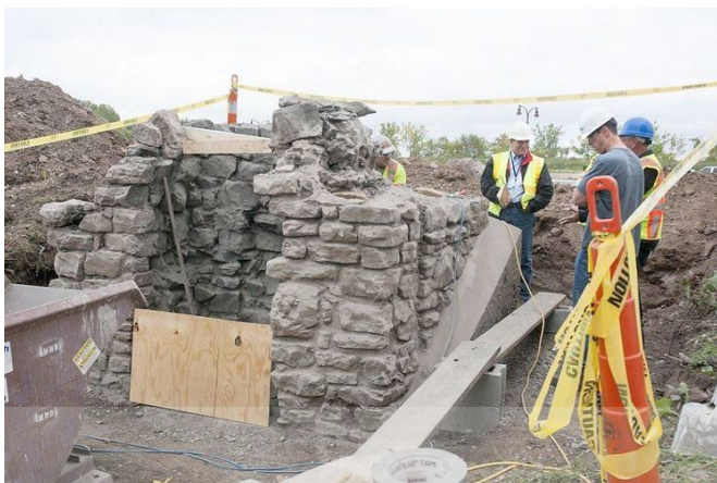
รูปที่ 2.15 การรื้อถอนแบบถอดเฉพาะบางส่วนของอาคาร
