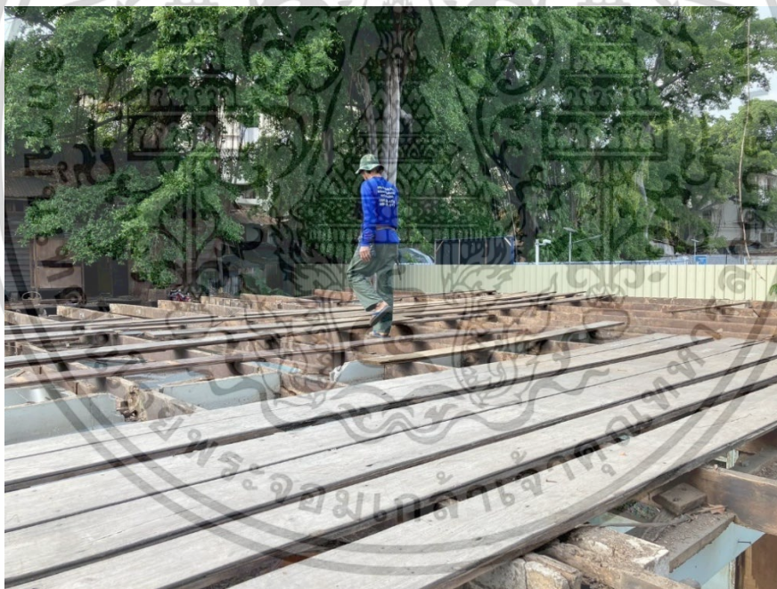
รูปที่ 4.24 การรื้อถอนพื้น
