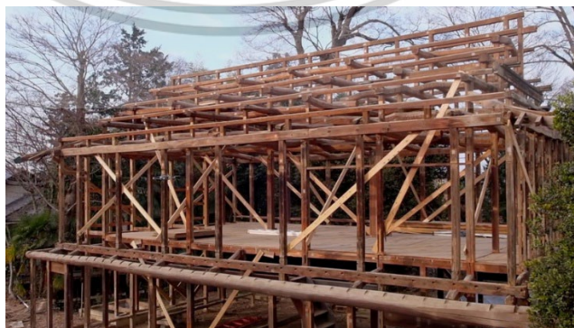
รูปที่ 2.10 การถอดชิ้นส่วนอาคารออกทั้งหมด
