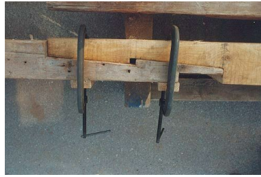
รูปที่ 2.18 การซ่อมแบบเปลี่ยนเฉพาะส่วนที่ผุเสีย
