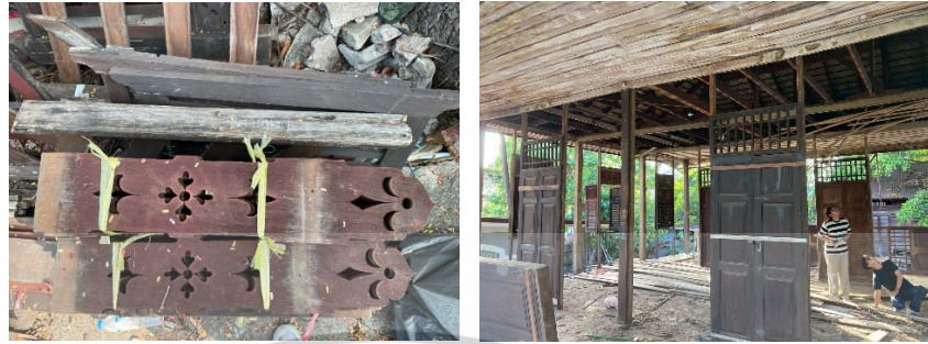
รูปที่ 4.77 องค์ประกอบผนังอาคาร
