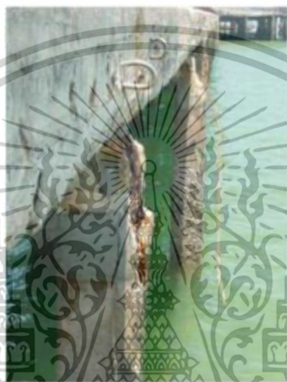
รูปที่ 1.3 แสดงปัญหาการเกิดสนิมของเหล็กเสริม ที่มา : วารสารคอนกรีต (2020)
