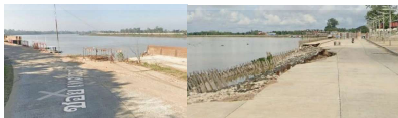
ภาพที่ 2.11 ภาพแสดงพื้นที่เขื่อนกันตลิ่งที่พังลงจากการกัดเซาะที่รุนแรงของน้ำ
