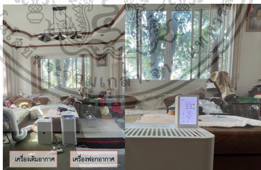
รูปที่ 4.20 แสดงภาพการติดตั้งเครื่องมือฟอก - เติมอากาศ และตรวจวัดฝุ่น PM 2.5 บ้านหลังที่ 4 ที่มา : ผู้วิจัย (2567)
