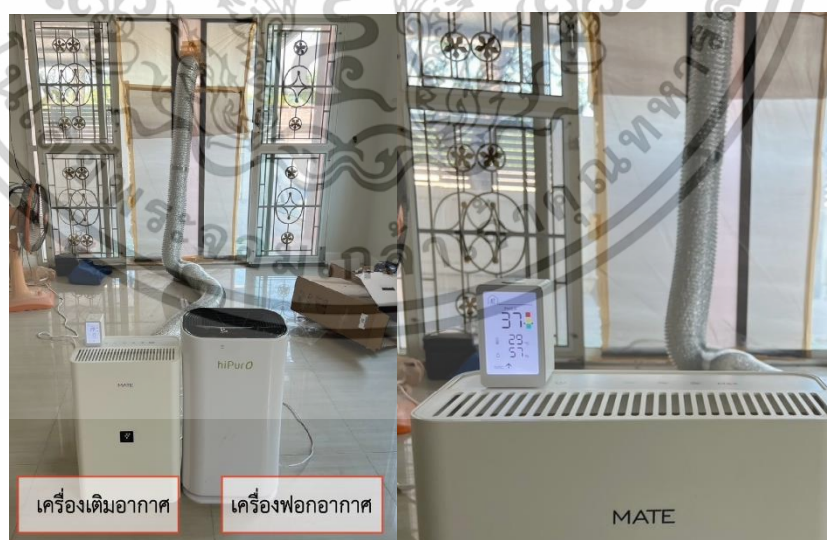
รูปที่ 4.25 แสดงภาพการติดตั้งเครื่องมือฟอก - เติมอากาศ และตรวจวัดฝุ่น PM 2.5 บ้านหลังที่ 5 ที่มา : ผู้วิจัย (2567)
