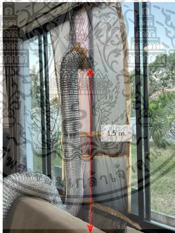
รูปที่ 3.4 แสดงการติดตั้งเครื่องเติมอากาศ
