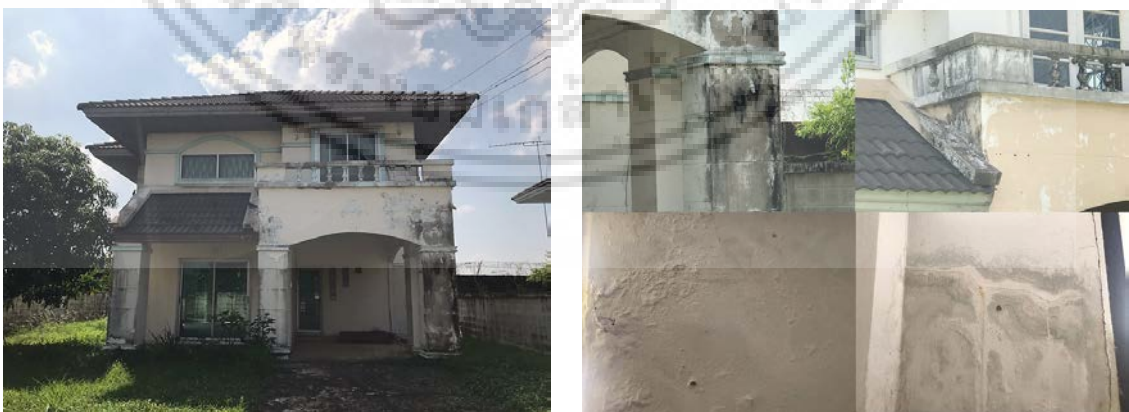
รูปที่ 1.1 ภาพการเสื่อมโทรมของอาคารจากปัญหา รา ตะไคร่ และรอยรั่ว
