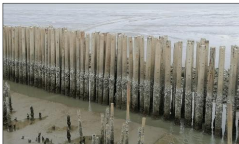
แนวเสาคอนกรีต
