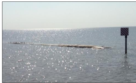
เขื่อนกันคลื่นแบบถุยสังเคราะห์ทางธรณี
