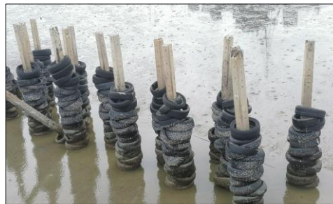
แนวเสาคอนกรีตสวมยางรถยนต์
