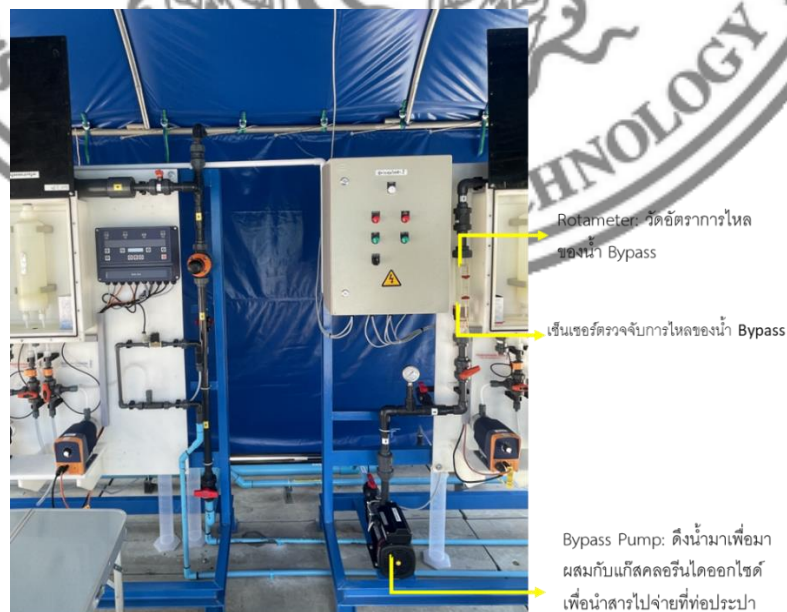
ภาพที่ 2.4 ตำแหน่งอุปกรณ์จ่ายน้ำและตรวจวัดการส่งน้ำ
