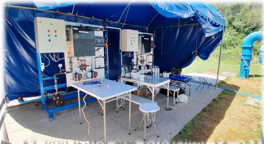
ภาพที่ 3.1 เครื่องจ่ายสารฆ่าเชื้อคลอรีนไดออกไซด์ ขนาดกำลังผลิตไม่น้อยกว่า 220 กรัมต่อชั่วโมง
