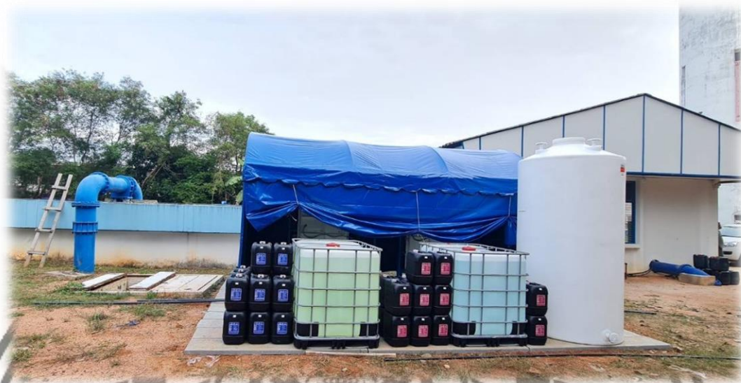
ภาพที่ 3.2 ถังบรรจุสารเคมี กรดไฮโดรคลอริก 9% และ โซเดียมคลอไรท์ 7.5% และถังน้ำใช้ในการทดลอง
