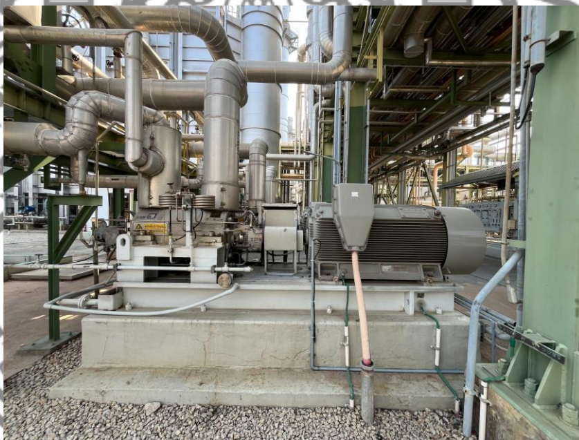
รูปที่ 2.4 เครื่องสูบน้ำป้อนหม้อไอน้ำในกระบวนการผลิตไฟฟ้า
