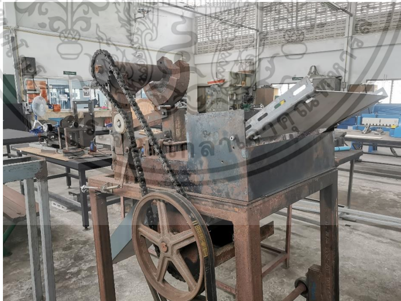
รูปที่ 3.9 การติดตั้งชุดรองรับมันสำปะหลังแผ่น
