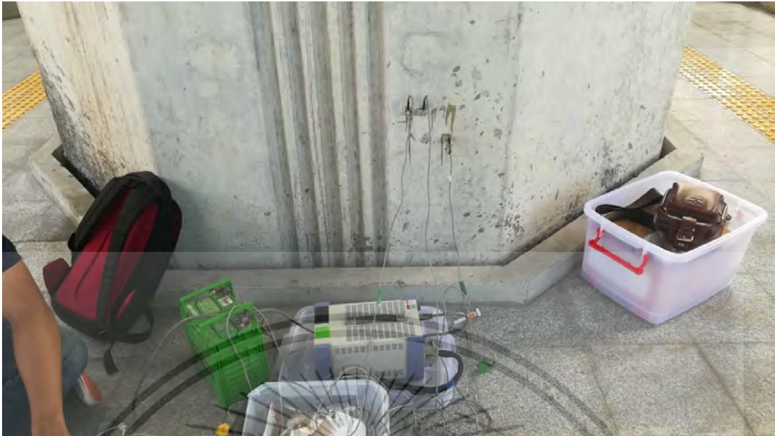
รูปที่ 8-11 การติดตั้งอุปกรณ์วัดความแรงกับเสาไฟฟ้า BTS
