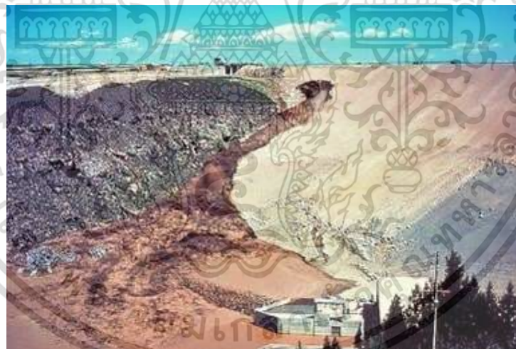
รูปที่ 2.4 รูปแสดงการรอดซึมผ่านของน้ำในเขื่อน จนเกิดการพังทลาย (Teton Dam)
