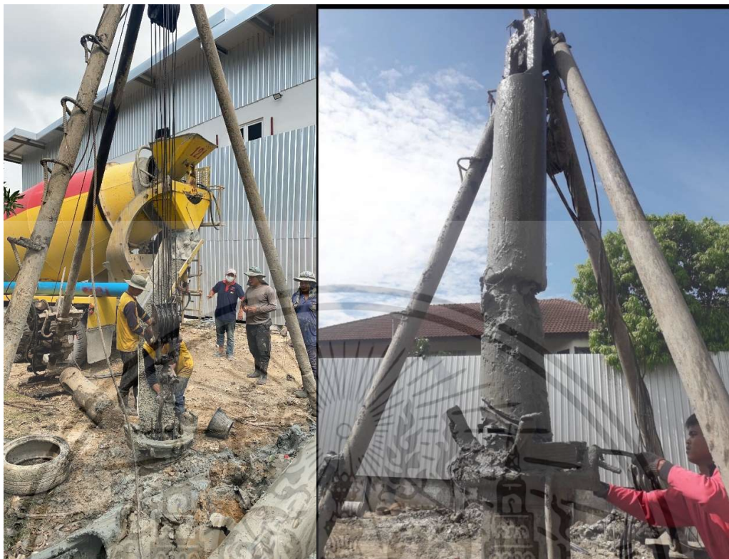
รูปที่ 2.1 แสดงการติดตั้งเสาเข็มเจาะของอาคาร
