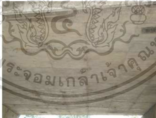
รูปที่ 2.1 สะพานคอนกรีตเสริมเหล็กแบบหล่อในที่ (Slab type)
