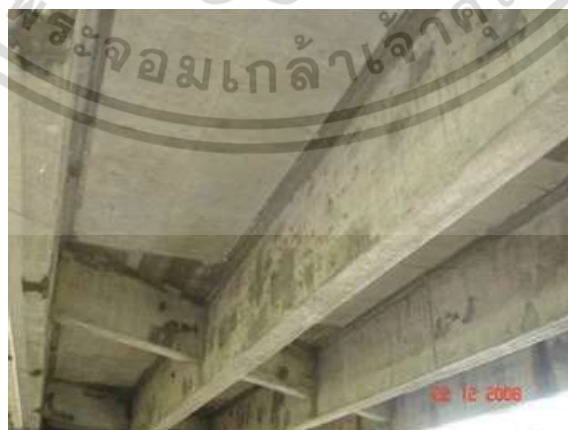
รูปที่ 2.5 สะพานแบบคานคอนกรีตรูปตัวที (T-girder)
