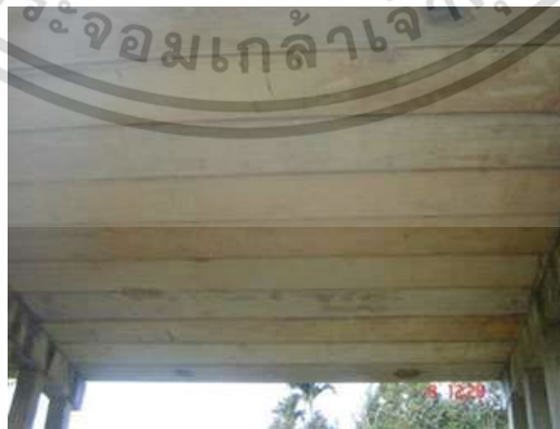
รูปที่ 2.3 สะพานแบบคอนกรีตอัดแรงแบบตัน (Plank girder)
