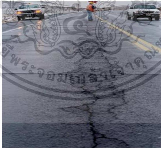
รูปที่ 2.4 การแตกล้าที่มีสาเหตุมาจากการหลุดร่อน
