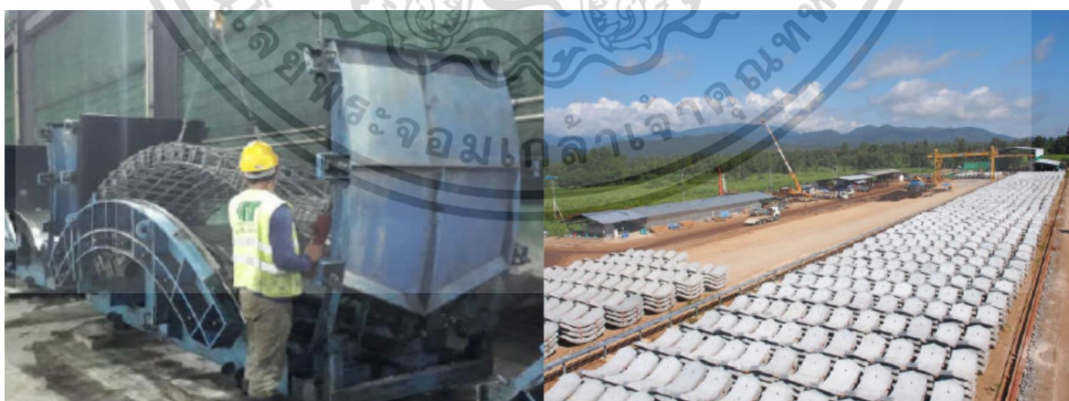
รูปภาพที่ 3.6 การหล่อผนังอุโมงค์ของวิธีการ TBM
