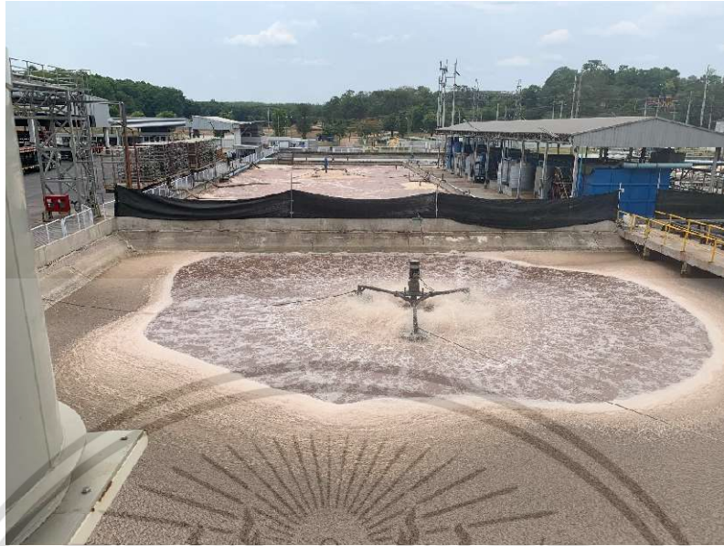
รูปที่ 2.2 ลักษณะน้ำตะกอนส่วนเกินก่อนผ่านกระบวนการทำตะกอนชั้น
