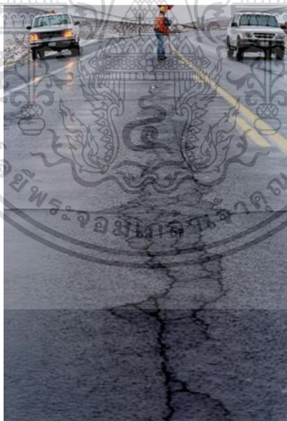
รูปที่ 2.6 การแตกล้าที่มีสาเหตุมาจากการหลุดร่อน
