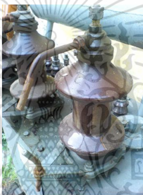
รูปที่ 2. 5 ตัวอย่างล่อฟ้าหรืออาร์คชิงฮอร์น [10]
