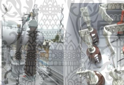
รูปที่ 2. 2 ตัวอย่างลูกถ้วยแรงสูงและลูกถ้วยแรงต่ำ [7]
