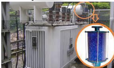
รูปที่ 2. 6 ชุดกรองความชื้นหม้อแปลงไฟฟ้า [11]
