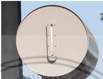
รูปที่ 2. 7 ตัวอย่างถังพักน้ำมัน [12]
