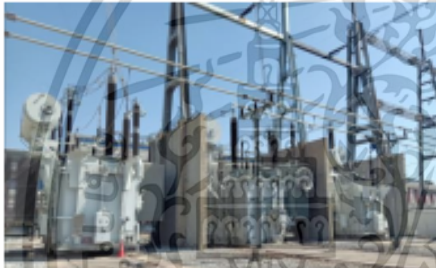
รูปที่ 2 หม้อแปลงไฟฟ้าจำนวน 3 ลูก ที่ถูกติดตั้งในสถานีไฟฟ้าวังน้อย จังหวัดพระนครศรีอยุธยา
