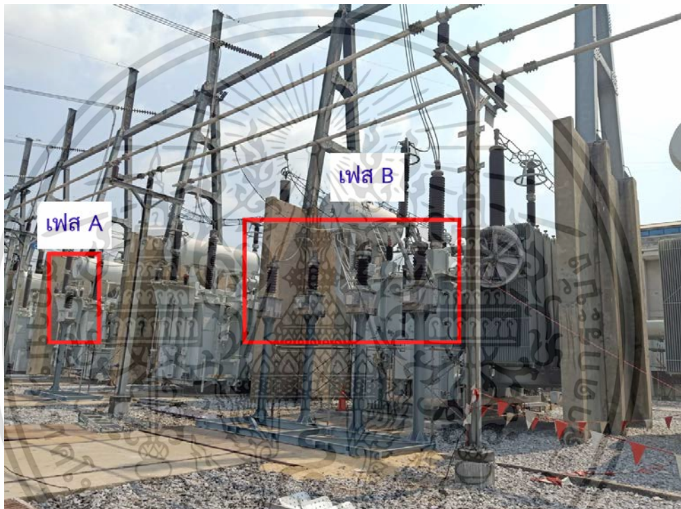
รูปที่ 4.11 การติดตั้งหม้อแปลงวัดแรงดันแบบตัวเก็บประจุขนาด
