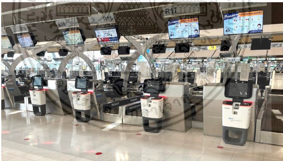
รูปที่ ค.8 แสดงการติดตั้งระบบปรับกระเป๋าสัมภาระอัตโนมัติ (CUBD)
