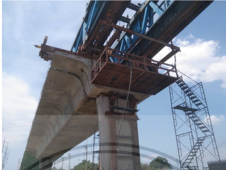
ภาพที่ ก. 10 ติดตั้งกระเช้าดึงลวดอัดแรง
