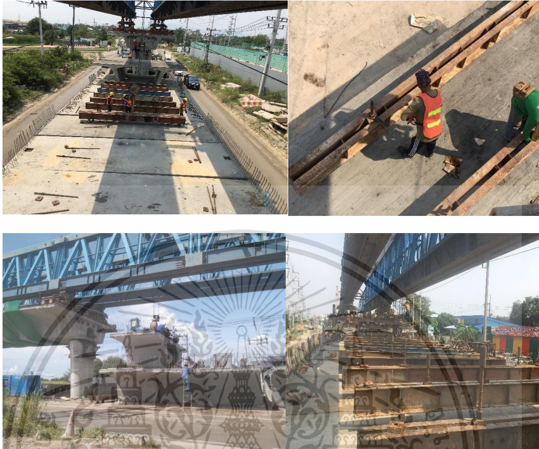
ภาพที่ ก. 8 ติดตั้ง Lifting Beam ที่ขึ้นส่วน Segment
