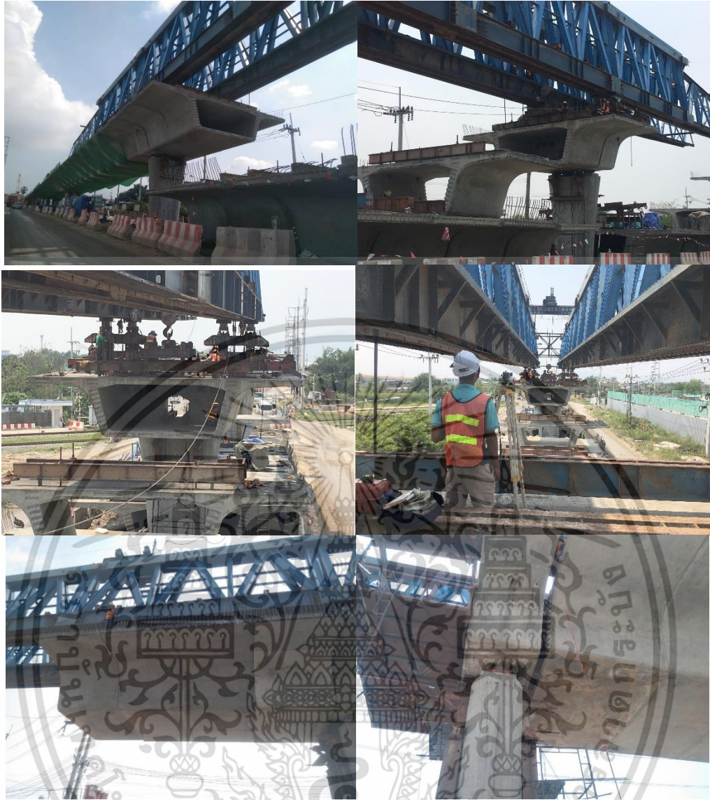
ภาพที่ ก. 9 ติดตั้งและจัดชิ้นส่วน Segment
