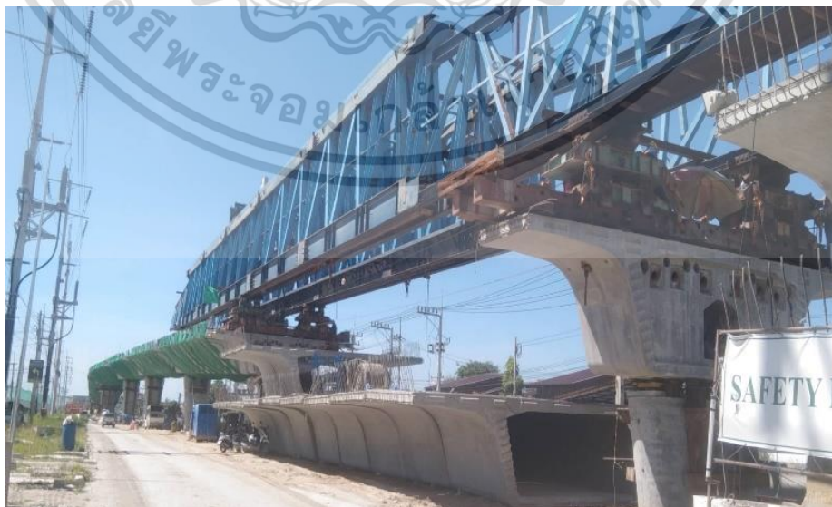
ภาพที่ 2.7 Over Head Truss
