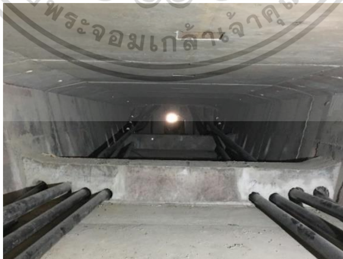
ภาพที่ 2.9 ชิ้นส่วน Deviator Segment
