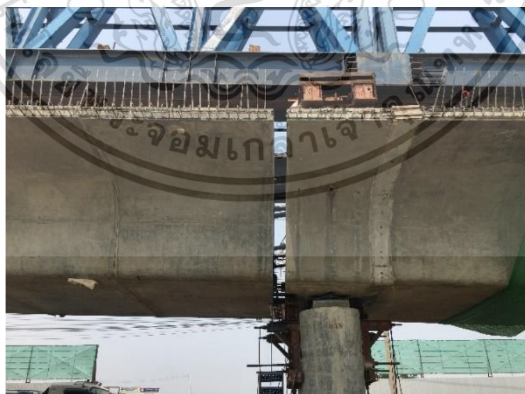
ภาพที่ 2.17 Wet Joint
