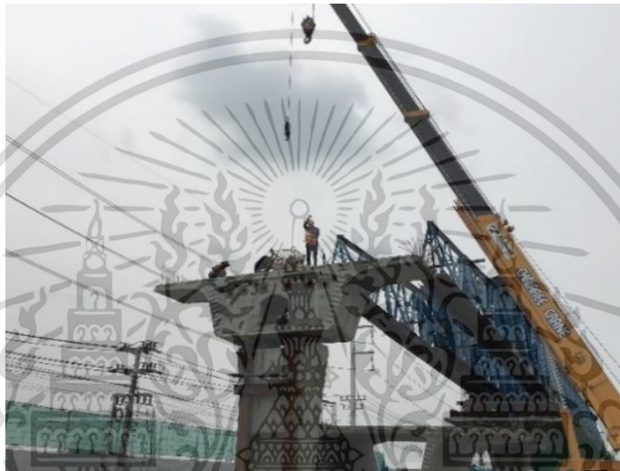
ภาพที่ 2.8 ชิ้นส่วน Pier Segment
