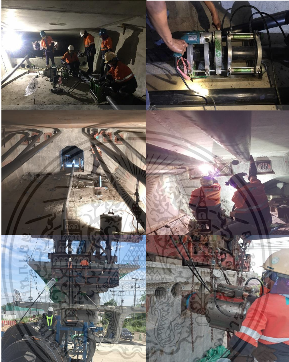
ภาพที่ ก. 12 เดินท่อร้อยลวดอัดแรงและดึง 15%
