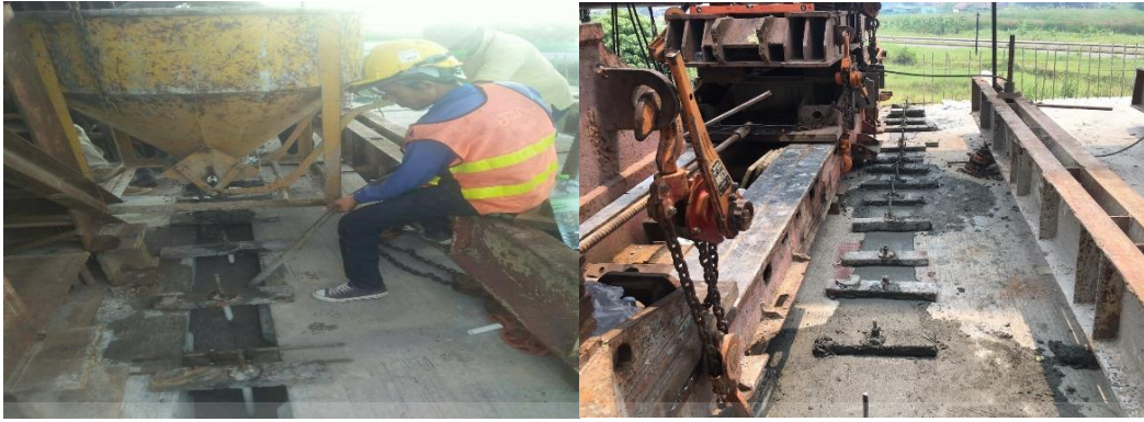
ภาพที่ ก. 13 เทคอนกรีต wet joint
