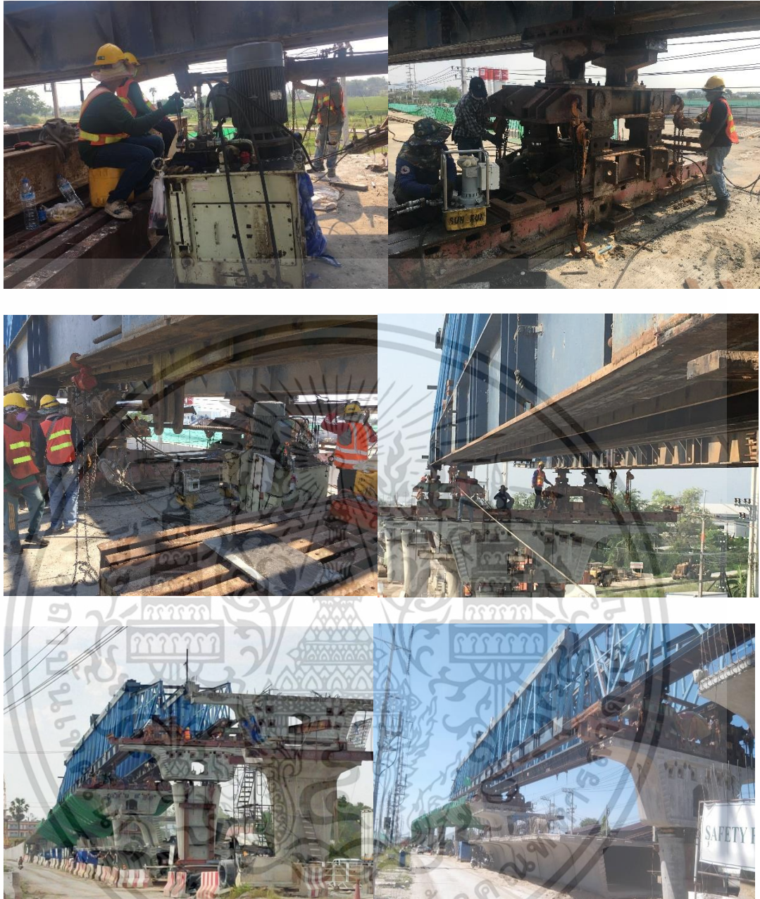
ภาพที่ ก. 7 เลื่อน Launching gantry เข้าตำแหน่ง
