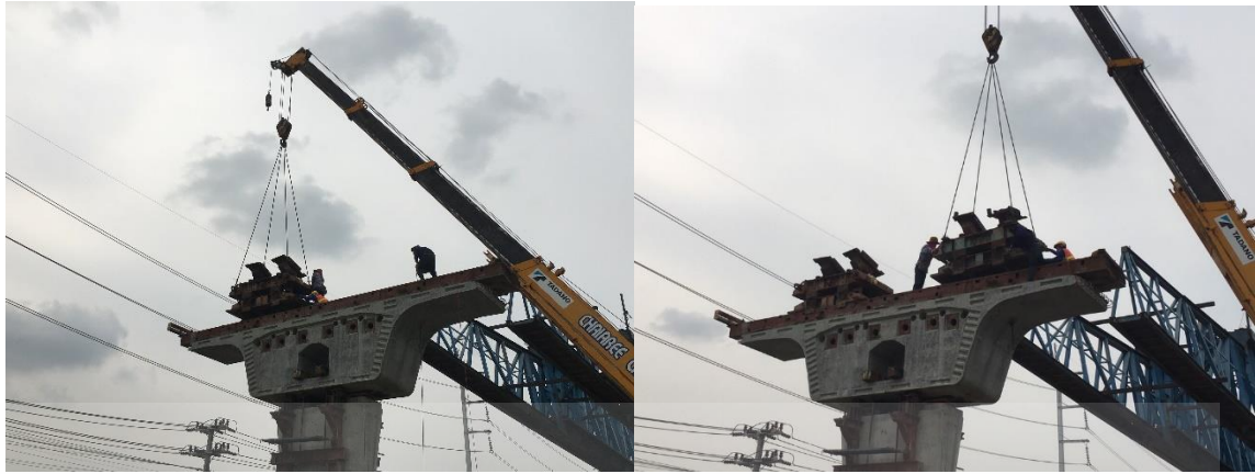
ภาพที่ ก. 3 การติดตั้ง Support
