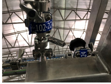
- ปิดวาล์ว HV100-22 เนื้อเครื่องบรรจุ
