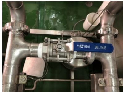
- เปิดวาล์ว VHU2104-01 บนเพลทชีวเลอร์
