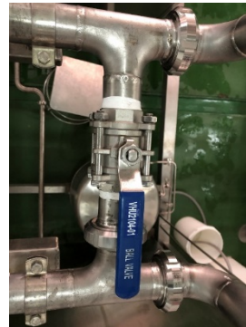
- เปิดวาล์ว VH2104-01 บนเพลทฮีวเลอร์
