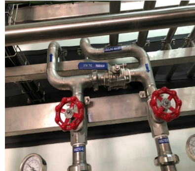
- เปิดวาล์ว VH2103-01 บนเพลทคูลิ่งค
