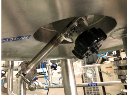
- ปิดวาล์ว HV-101-18 ได้ถึง
