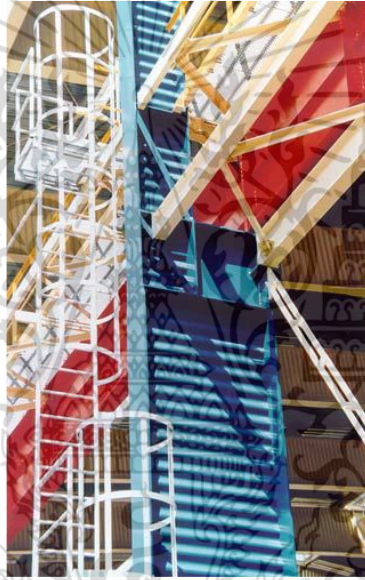
รูปที่ 1 เสาหน้าตัดรูปตัวไอที่มีแผ่นเอวเป็นลอน (Corrugated web I-section column) [1]
