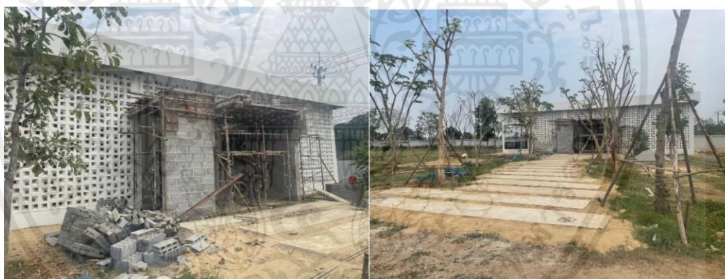
ภาพบริเวณไซต์งานก่อสร้าง
