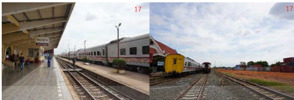
ภาพที่ 4.42 สภาพแวดล้อมบริเวณภายในสถานีรถไฟหนองคาย
