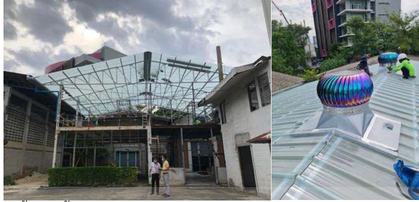
ภาพที่ 2.9 ติดตั้งกระเบื้องหลังคาโปร่งแสงและลูกหมุนระบายอากาศบนหลังคา ศูนย์เกษตรวิถีเมือง (สำนักงานการวิจัยแห่งชาติ), กรุงเทพมหานคร. (ศูนย์เกษตรวิถีเมือง (วช.), 2565)
