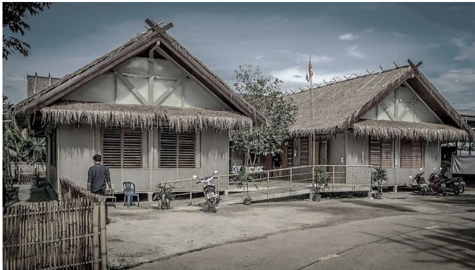
รูปที่ 2.9 แสดงภาพอาคารหลังก่อสร้างเสร็จ ที่มา : Spacetime .กา-ละ-เท-ศะ (2558)
