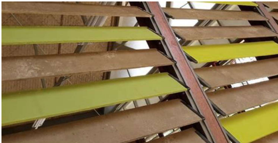
รูปที่ 2.13 แสดงภาพการระบายอากาศด้วยหน้าต่างบานเกร็ดที่ทำจากซีเมนต์บอร์ด ที่มา : ผู้วิจัย (2564)
