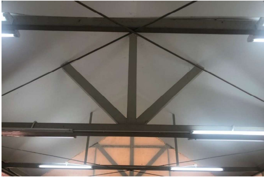
รูปที่ 5.4 แสดงภาพฝ้าเพดานภายในอาคารที่ทำจากฝ้ายิปซัม หลังการปรับปรุง ที่มา : ผู้วิจัย (2566)
