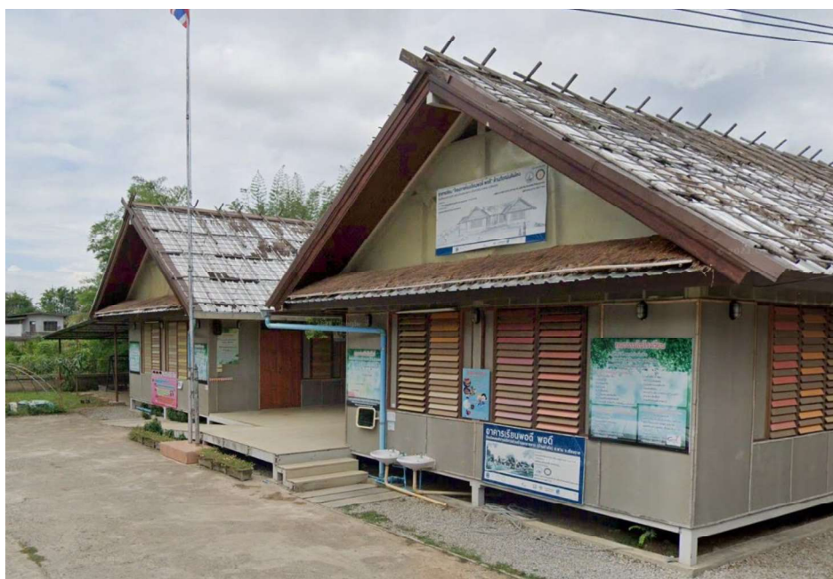
รูปที่ 2.17 แสดงภาพภายนอกอาคารอนุบาล ที่มา : ผู้วิจัย (2564)
