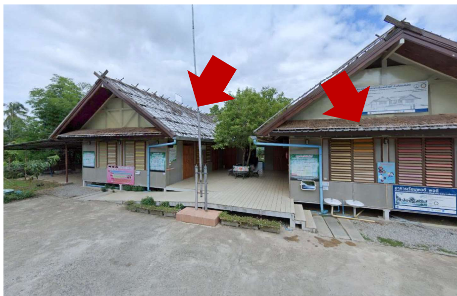
รูปที่ 1.1 แสดงภาพตบหญ้าคา วัสดุบุหลังคาชั้นที่สองเกิดการหลุดร่วงไปจนหมด ที่มา : ผู้วิจัย (2564)
