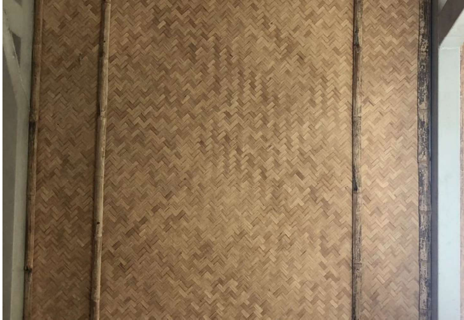
รูปที่ 2.18 แสดงภาพฝ้าภายในที่ทำด้วยเสื่อลำแพน ที่มา : ผู้วิจัย (2564)
