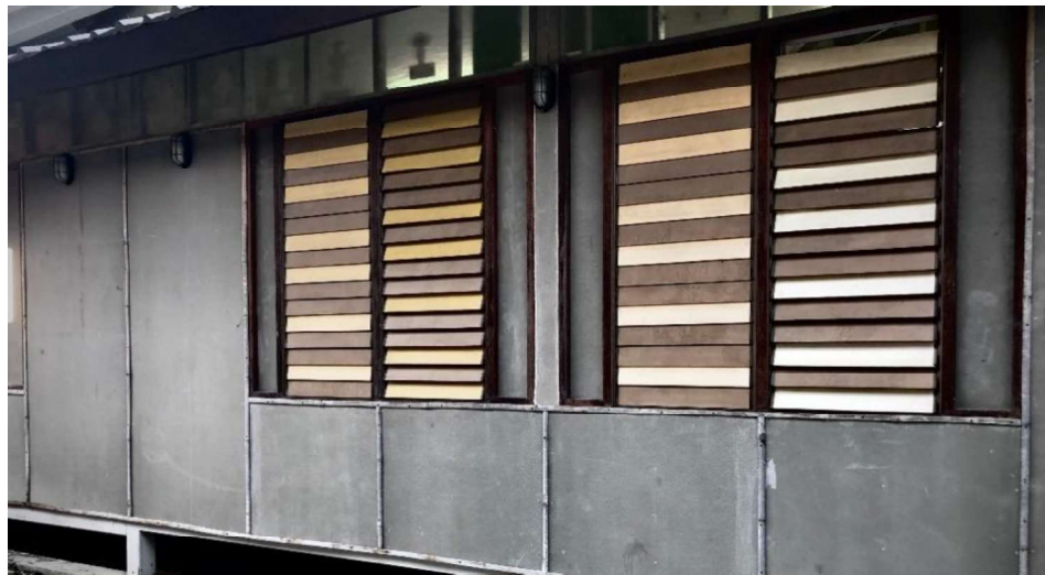
รูปที่ 2.11 แสดงภาพผนังอาคารเรียนที่ทำจากซีเมนต์บอร์ด ที่มา : ผู้วิจัย (2564)
