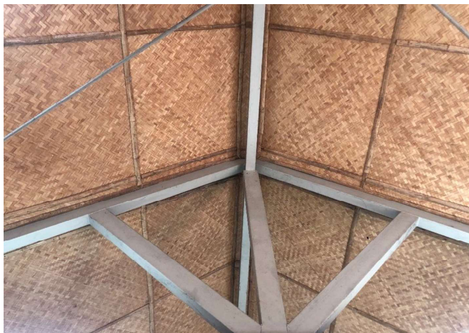
รูปที่ 5.3 แสดงภาพฝ้าเพดานภายในอาคารที่ทำด้วยเสื่อลำแพน ก่อนการปรับปรุง ที่มา : ผู้วิจัย (2564)
