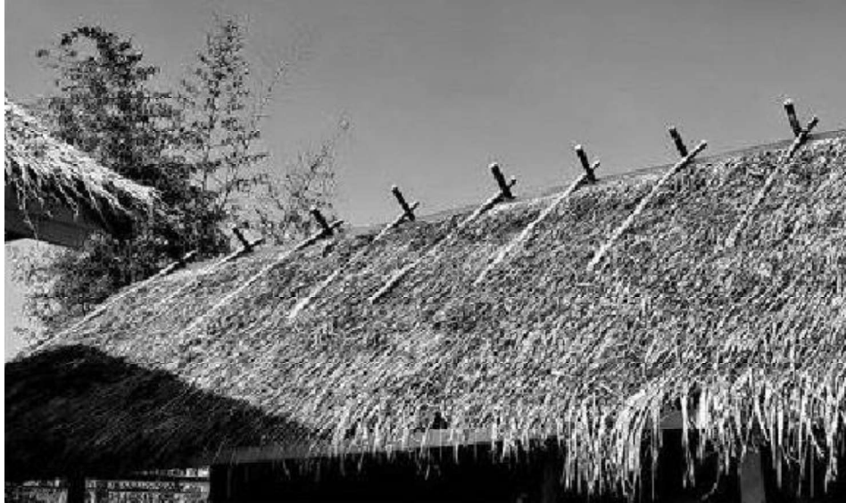
รูปที่ 2.10 แสดงภาพหลังคาอาคารเรียนที่มุงด้วยแผ่นเหล็กกรีดลอนและทับหญ้าคา ที่มา : Spacetime .กา-ละ-เท-ซะ (2558)
