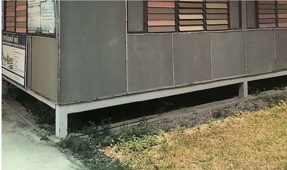
รูปที่ 2.12 แสดงภาพอาคารที่ยกพื้นสูงเพื่อเพิ่มการระบายอากาศและป้องกันน้ำท่วม ที่มา : ผู้วิจัย (2564)
