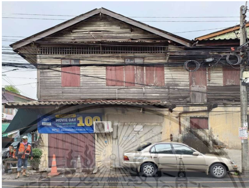
ภาพที่ 4.9 อาคาร 2 ชั้นแบบครึ่งตึกครึ่งไม้ที่มีหลังคาหน้าจั่ว
