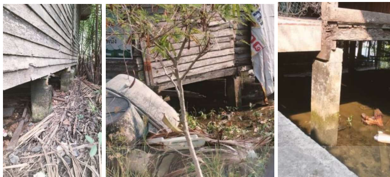
ภาพที่ 2.15 ใต้ถุนเรือน ไม่สูงมากนักเพียงพอให้คนเดินลอดผ่าน และหนีจากน้ำท่วม
