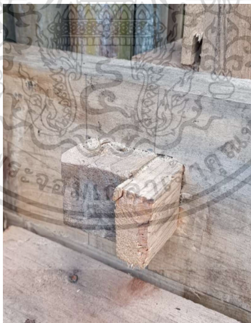
ภาพที่ 4. 62 การเชื่อมต่อโครงสร้างของยั้งฉาง Yilan - 3 ที่มา: ผู้วิจัย (2567)
