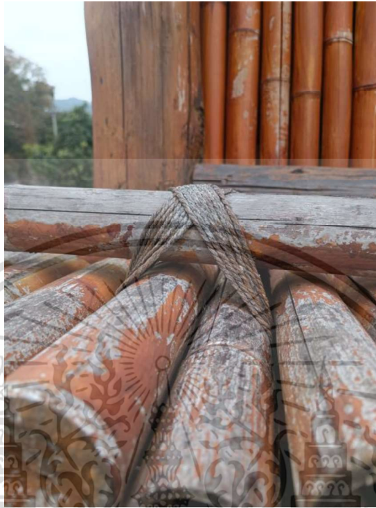
ภาพที่ 4.7 การเชื่อมต่อโครงสร้างของยั้งฉาง Taichung – 1 ภาพที่ 2 ที่มา: ผู้วิจัย (2567)
