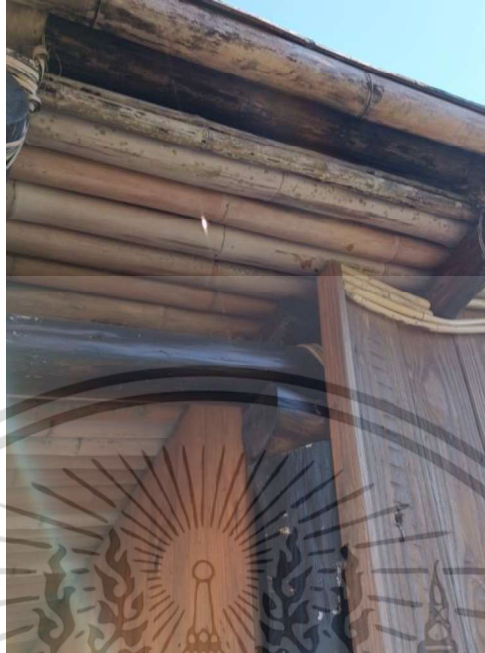
ภาพที่ 4. 77 การเชื่อมต่อโครงสร้างของยู่ฉาง Yilan - 5 ที่มา: ผู้วิจัย (2567)
