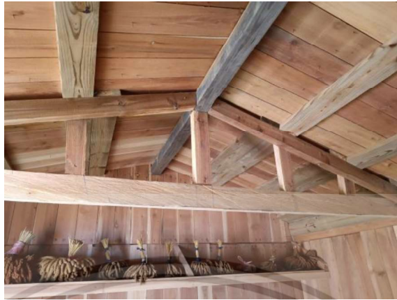
ภาพที่ 4. 39 โครงสร้างหลังคาของยุ้งฉาง Hsinchu - 1 ที่มา: ผู้วิจัย (2567)
