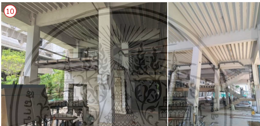
ภาพที่ 4.11 ภาพการปรับปรุงอาคาร นำพื้นชั้นลอยของชั้น 1 ออก
