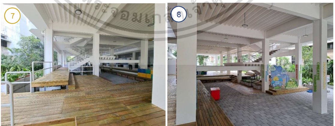
ภาพที่ 4.7 ภาพการปรับปรุงอาคาร ชานพื้นไม้ยางพารา และบันไดใหม่
