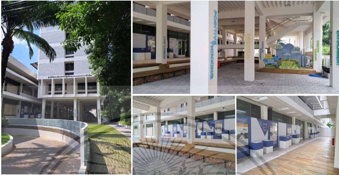
ภาพที่ 3.8 อาคารปรับปรุงแล้วเสร็จ ชั้นที่ 1
