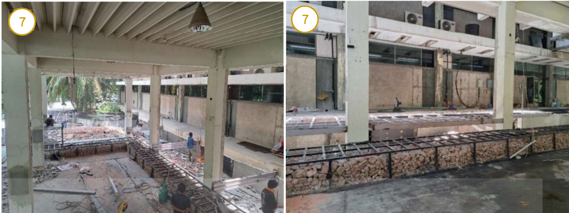
ภาพที่ 4.5 ภาพการปรับปรุงอาคาร การปรับระดับพื้นชั้น 1
