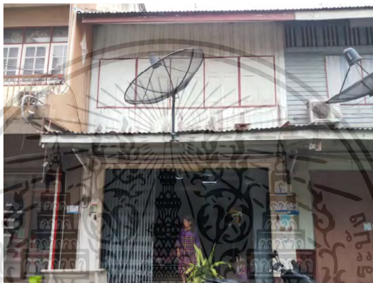
ภาพที่ 4.70 แสดงภาพภายนอก อาคารหลังที่ 11
