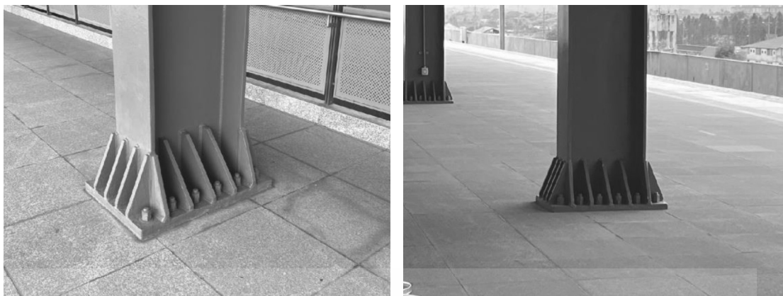
ภาพที่ 4.32 แสดงฐานรองรับโครงสร้างหลังคาสถานีจุดจักร (CC1) ที่มา : จากการสำรวจในเดือนมกราคม พ.ศ.2566
