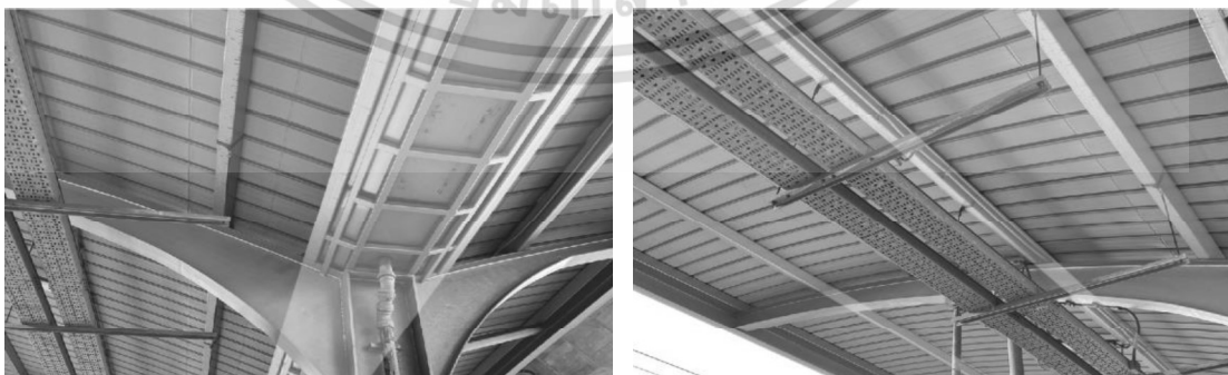
ภาพที่ 4.46 แสดงคานยึดรั้ง และแป ตามลำดับ
