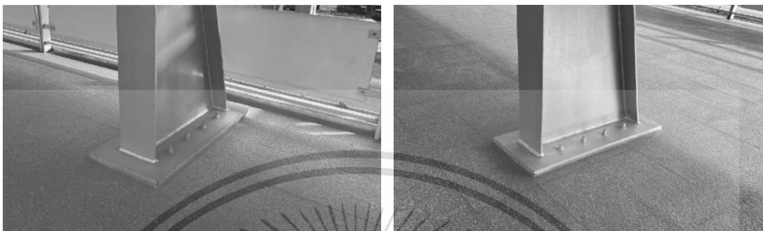
ภาพที่ 4.40 แสดงฐานรองรับโครงสร้างหลังคาสถานีบางช่อง ที่มา : จากการสำรวจในเดือนมกราคม พ.ศ.2566
