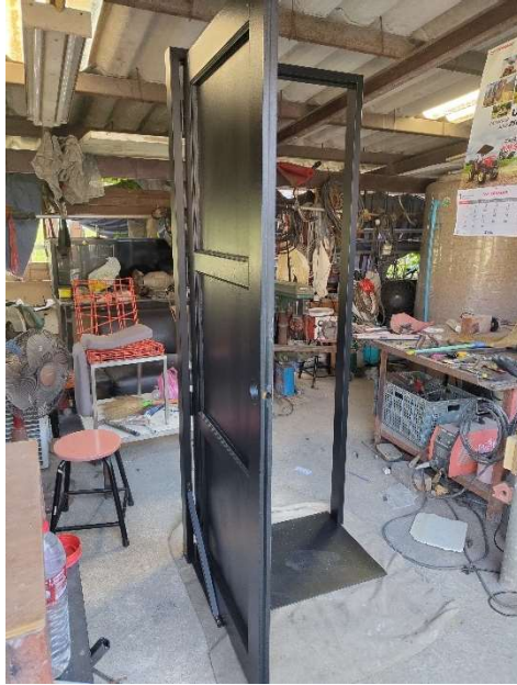
รูปที่ 3.36 ทาสีประตูเป็นสีดำและนำมายึดกับโครงเหล็ก
