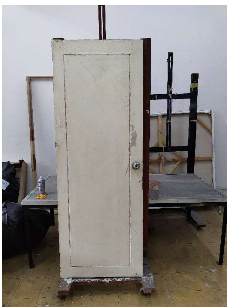
รูปที่ 3.35 เตรียมประตูสำหรับใช้ยึดกับโครงเหล็ก
