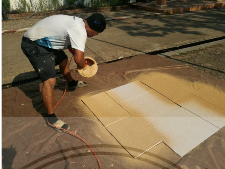
ภาพที่ 4.14 ทำการพ่นไปที่ชิ้นงานให้สม่ำเสมอ และมีชั้นความหนาตามต้องการ ที่มา : สหพรณ อารณ (2565)
