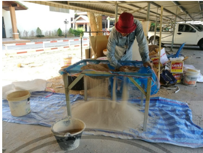
ภาพที่ 4.10 ร่อนทรายให้มีความละเอียดเท่ากัน ที่มา : สหพรรณ อารณ์ (2565)
