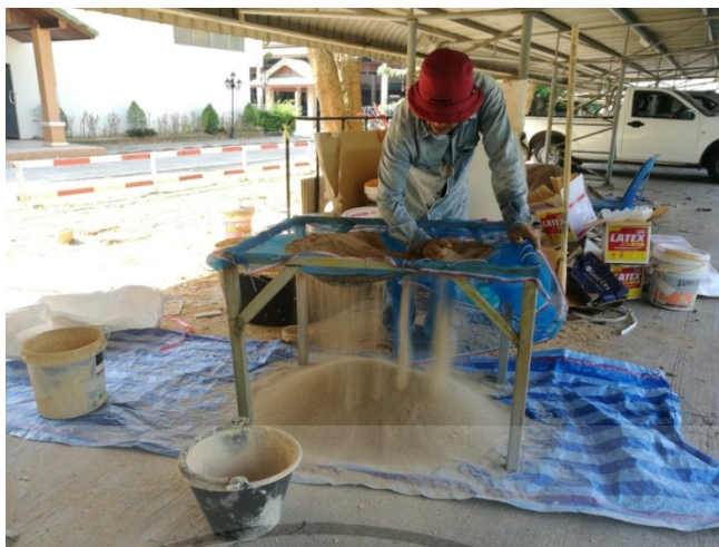
ภาพที่ ง.1 ร่อนทรายให้มีความละเอียดเท่ากัน
