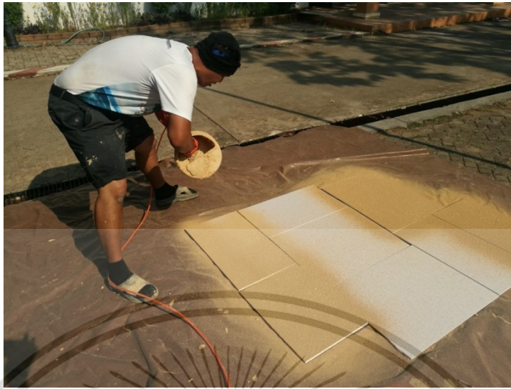
ภาพที่ ง.5 ทำการพ่นไปที่ชิ้นงานให้สม่ำเสมอและมีชั้นความหนาตามต้องการ ภาพโดย : สหพรณ อารณ (2565)
