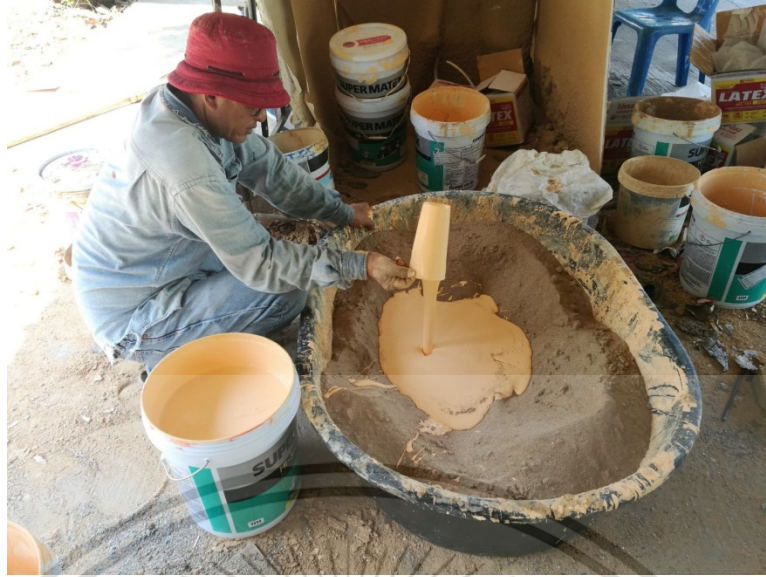
ภาพที่ 4.12 ผสมสีสำหรับพ่นขึ้นงาน ที่มา : สหพรณ อวารณ (2565)
