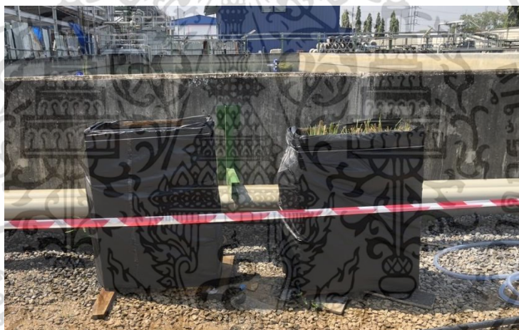
รูปที่ 3.5 สภาพปรากฏของบ่อควบคุมและบ่อดทดลองเมื่อน้ำถูกดำนาคูลม
